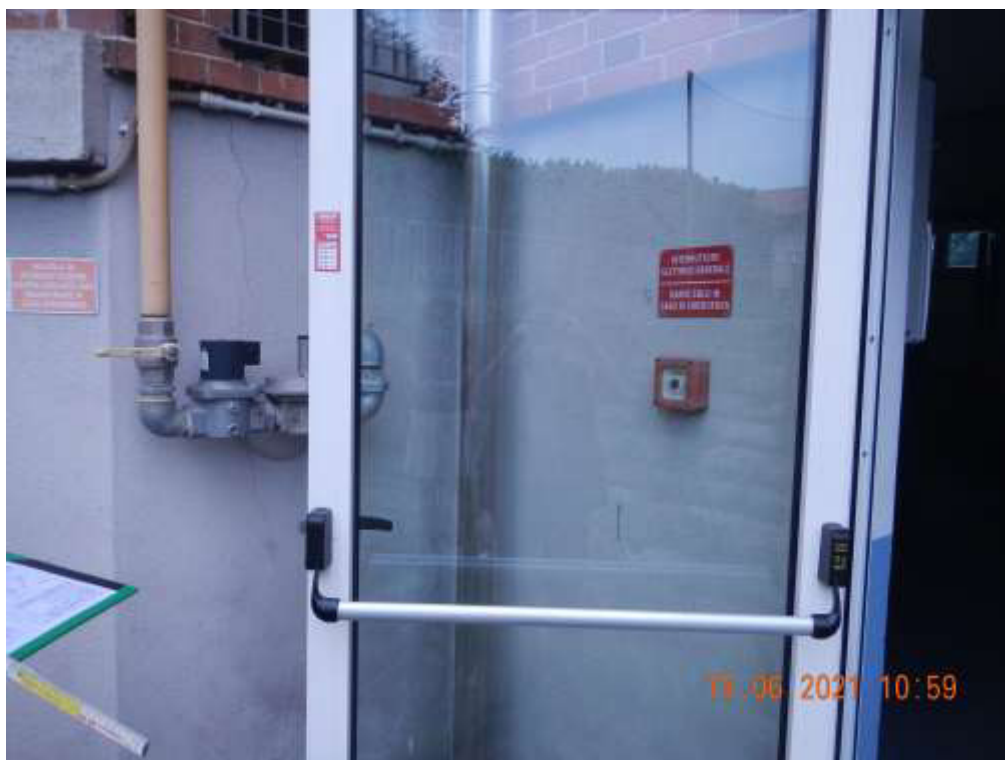
Figura 6 Valvola intercettazione combustibile esistente
