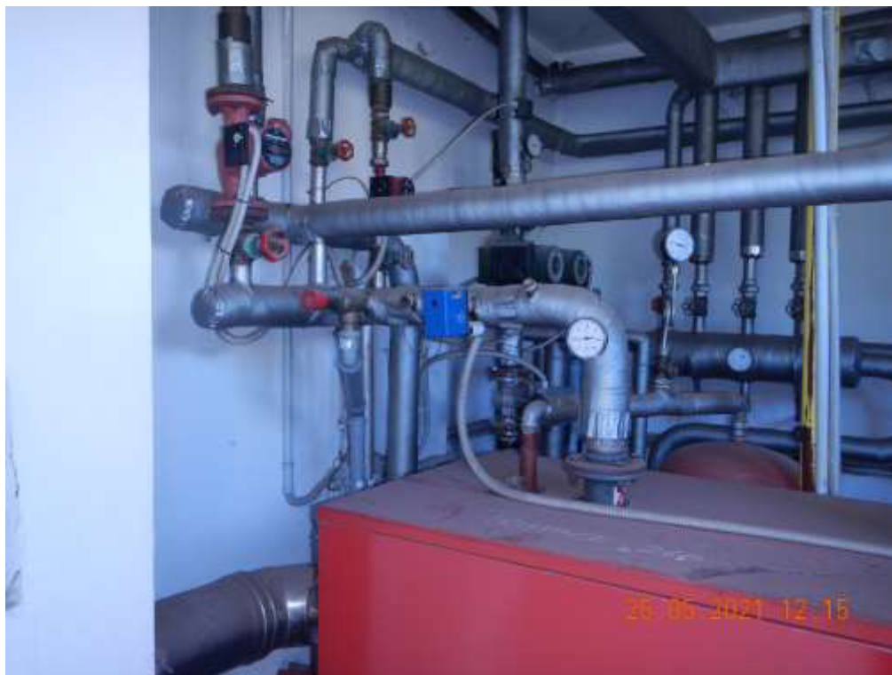
Figura 4 Sicurezze INAIL esistenti
